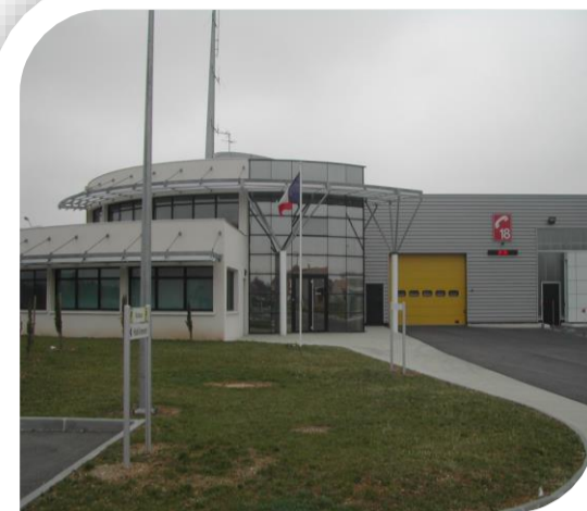
Caserne des sapeurs-pompiers de Romans
