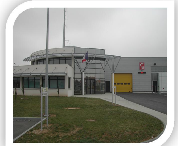
Caserne des sapeurs-pompiers de Romans
