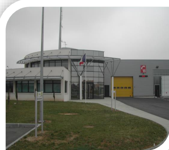
Caserne des sapeurs-pompiers de Romans
