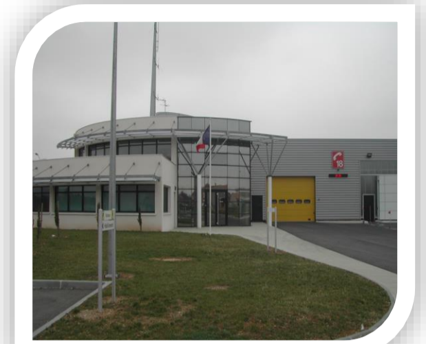
Caserne des sapeurs-pompiers de Romans
